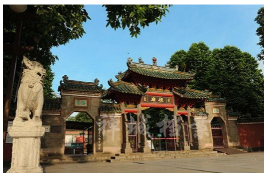
“修旧如故”：佛山祖庙 40 (来源：禅城区人民政府网站)
