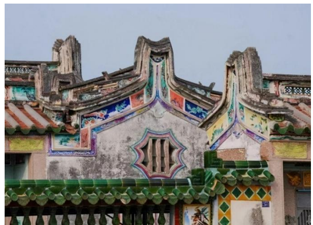
图 40 特色构造 厝角头：潮汕民居建筑特色 34 (来源：凤凰网古建家园，2020)
