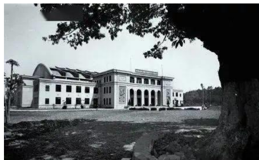
由岭南著名建筑师林克明主持设计的苏式建筑原广州体育馆因修建地铁而被爆破拆除 14 (来源：羊城网，2021)
